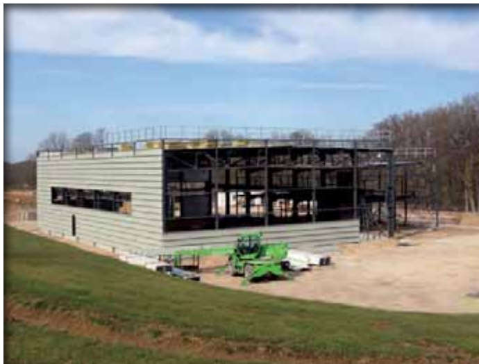
Le bâtiment est sorti de terre début janvier
