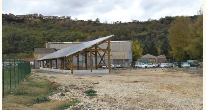
Première installée, l'entreprise Desroches.
