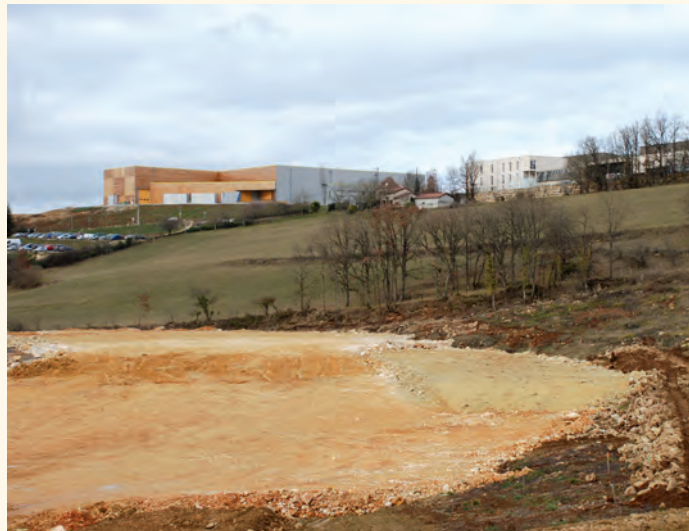
Le chantier début janvier.
