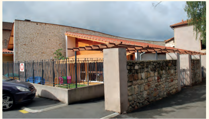
Une unité supplémentaire sera construite au-dessus de la partie halte-garderie actuelle.
