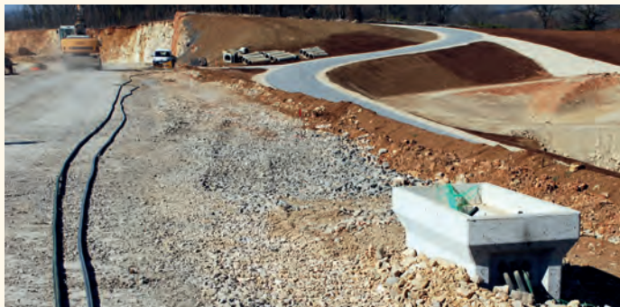
Sur le tracé de la déviation, avant la desserte de la zone d'activités de l'Aiguille.
