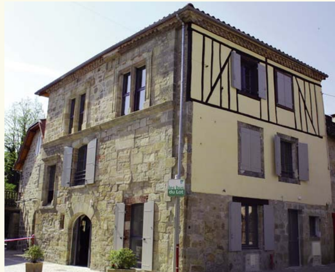
... et après travaux.
