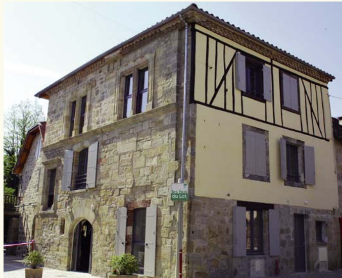
... et après travaux.
