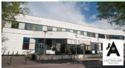
Réhabilitation de l'Astrolabe et création du réseau des médiathèques
