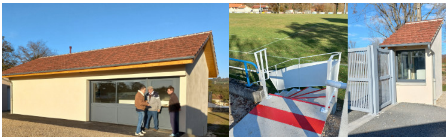
L'équipement est désormais doté de bureaux (30 m 2 ), d'un sanitaire règlementaire (12 m 2 ), d'une tribune accessible à tous et d'une billetterie située à l'entrée du stade.
