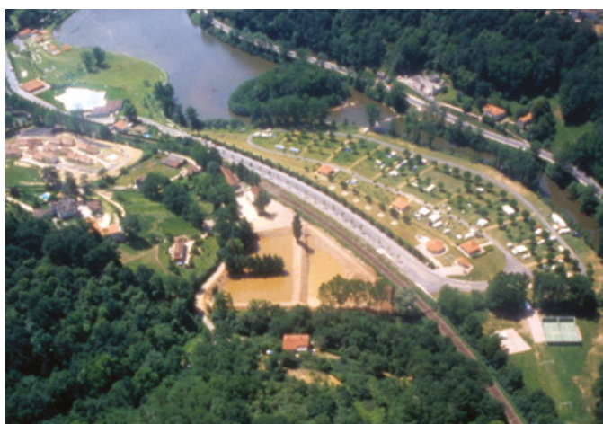
▲ Vue aérienne du Domaine du Surgié en 1993. Le camping ne dispose pas encore de mobil homes et seule la 1ère tranche des Oustalous est construite.
