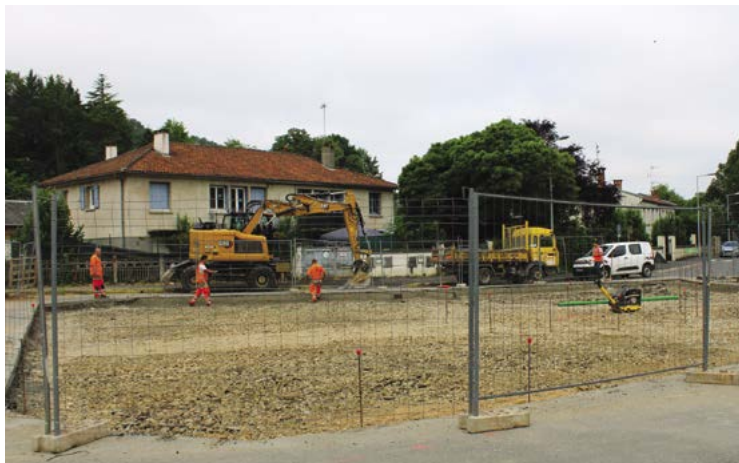
Le chantier mi-juin.
