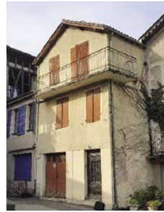
L'immeuble avant et après travaux.
