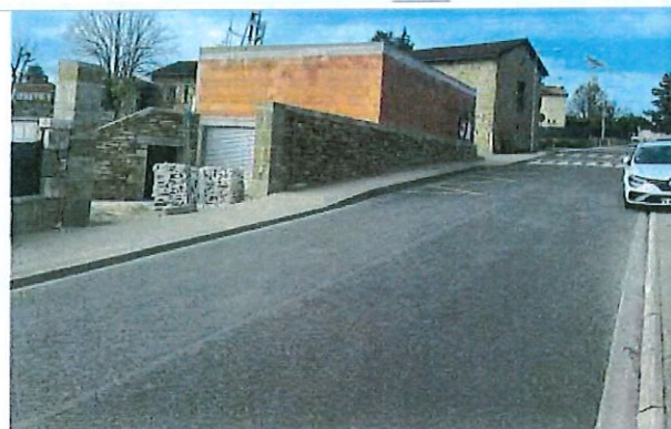
Figure 3- Vue de la rue sur futur passage bateau
