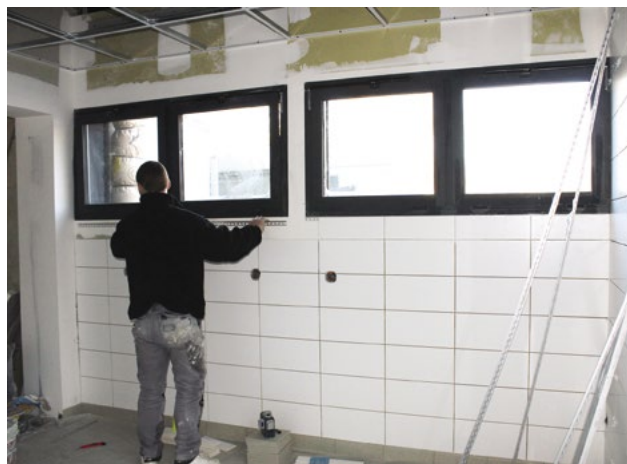
Les travaux en cours mi-janvier.
