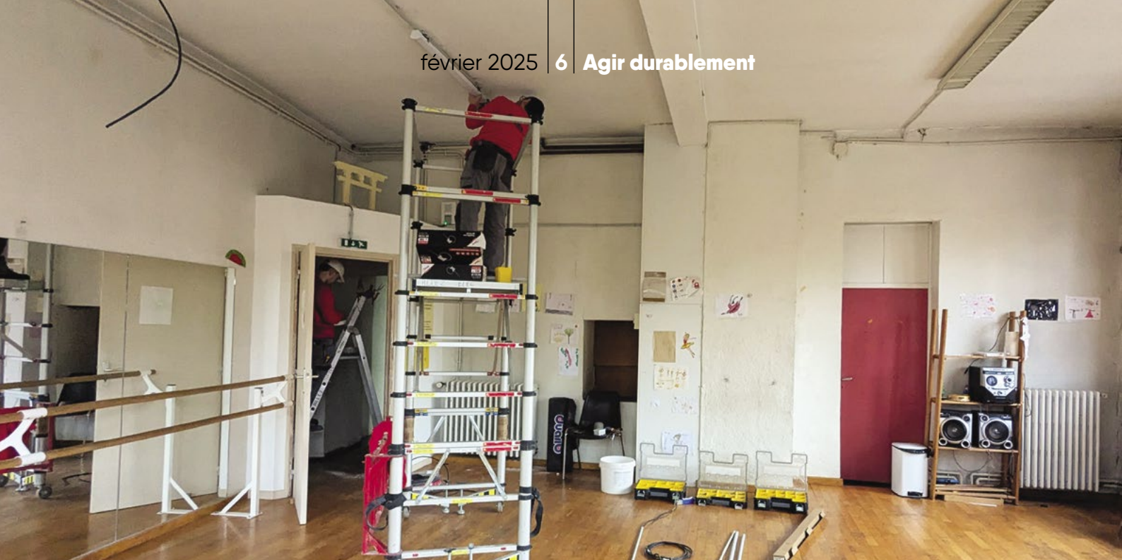
A l'ancien CES, remplacement des anciens néons par une rampe Led dans la salle de danse du rez-de-chaussée.
