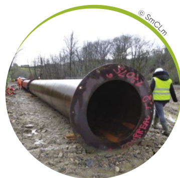
Montage de la future conduite qui permettra de sécuriser les réseaux traversant le Célé.
