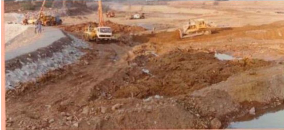
31 octobre 1985, construction du seuil, source: Ville de Figeac
