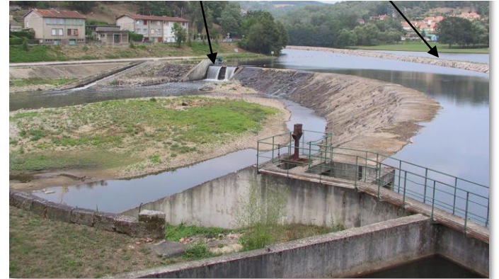
Digue du plan d'eau vue depuis le moulin, juillet 2019
